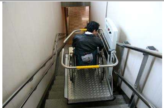
지하철역 휠체어 리프트
